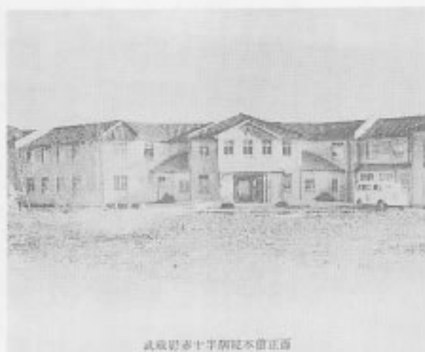
武蔵野赤十字病院本館正面
